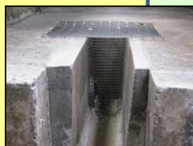
排水溝等からの侵入防止対策 (鉄格子の設置)
