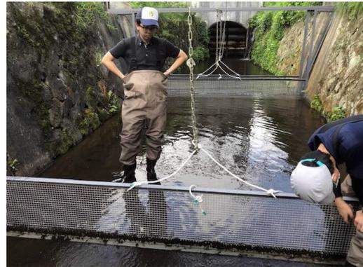
写真1 調査地点Aの逸出魚防止装置（従来の装置（写真左）、今年度取り替えた装置（写真右）
