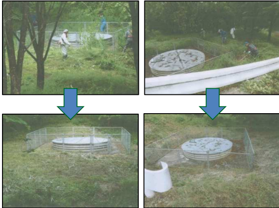
集水井周辺の草刈り (長野市中条 成山砂防ボランティア R2年5月)
