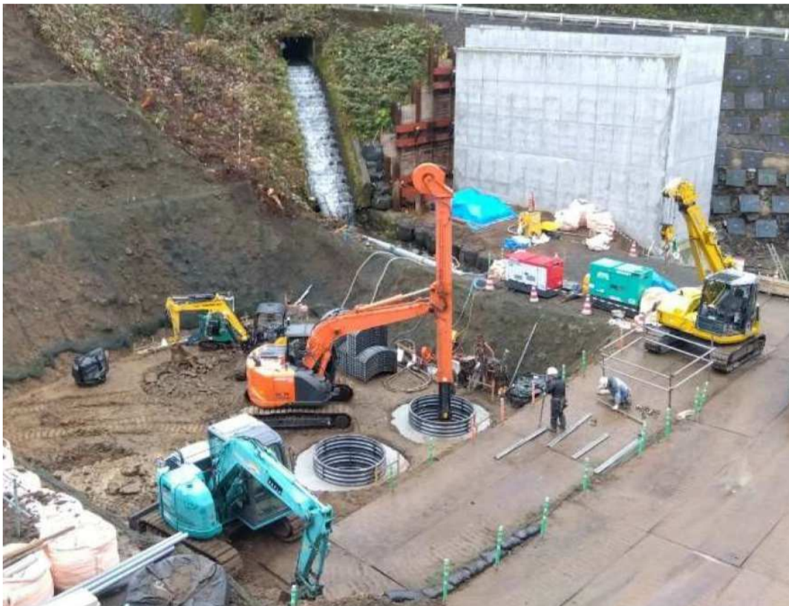
深礎工法実施時の様子です
