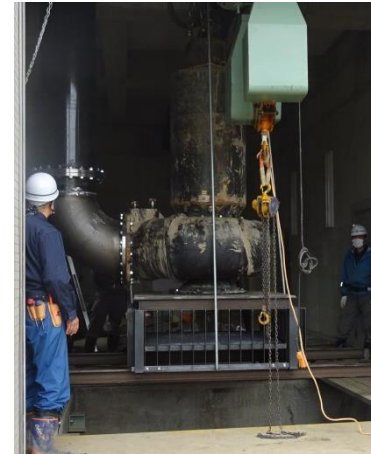
・仮設ポンプ設置の様子
