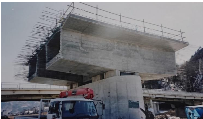
橋脚上に施工された柱頭部(平成12年)
