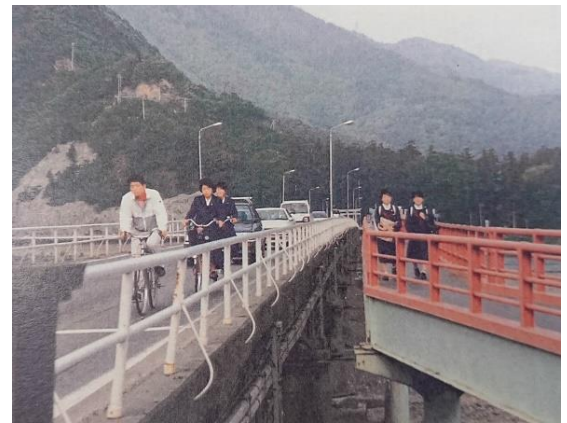
旧大正橋と赤い高欄の歩道(右側)(昭和41年)
