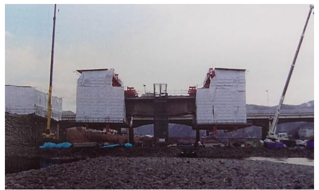
ワーゲンにより柱頭部から両側へ張出し施工部を伸ばし、隣の柱頭部からの張出し施工部と連結させる。(平成13年)
