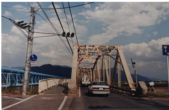
← 右岸からの旧千曲橋。左（青色）は県営水道の水道橋（昭和60年）
