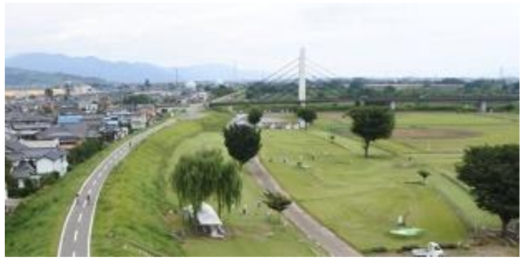
左岸の千曲橋緑地と上田千曲長野自転車道（左端）
