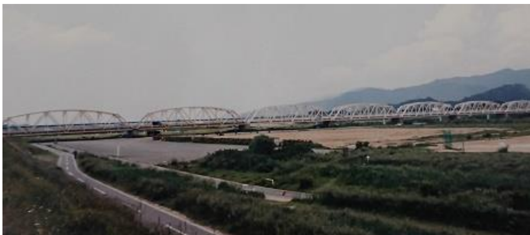
旧橋全景 連続する7つのトラス（左岸から）
