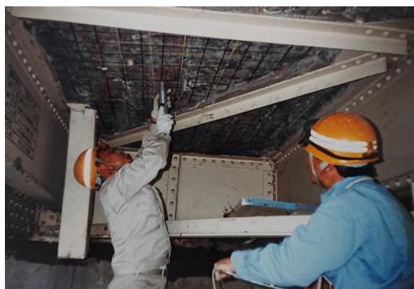
↑ 橋梁点検。床版下面コンクリートの状況を調査（昭和60年）
