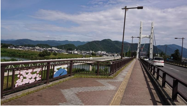
左岸（稲荷山側）から千曲橋の歩道を渡る。待避所スペースには、あんずの花と棚田の月のレリーフ。杭瀬下方面に建設中の千曲市本庁舎が見える。（平成30年8月）
