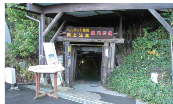
写真8 松代地下壕入口
