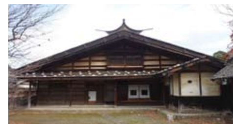
ほりうちけいじゅうたく 堀内家住宅 (国重要文化財:塩尻市) 江戸時代中期建築
