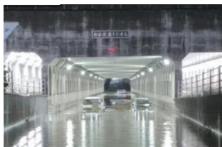
《アンダーパスの冠水》
