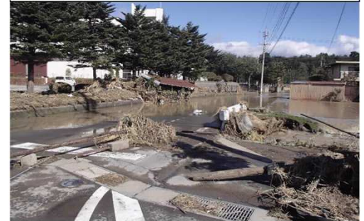
R01.10.13 09:10頃(1.5k決壊箇所下流側 県道139号)
