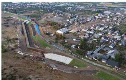
↑仮締切堤 (R元.10.30)
