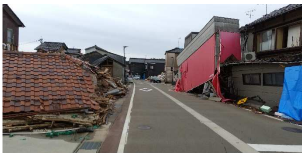
←被災した駅前商店街（穴水町）
