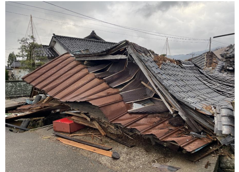
▲倒壊家屋の状況（1/6撮影）
