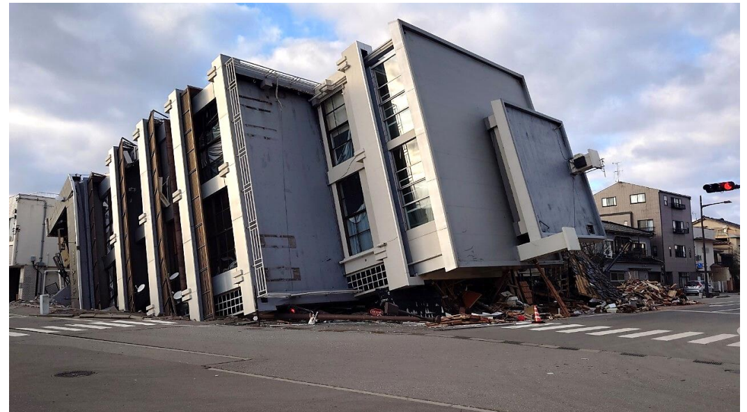
▲倒壊家屋の状況（1/8撮影）
