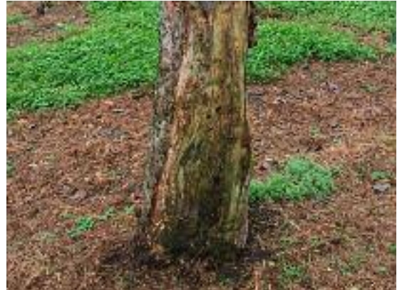
図4 主幹地際部の腐朽症状
