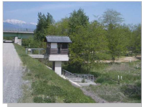
放流渠（放流施設） 光橋のすぐ下流に設置されています
