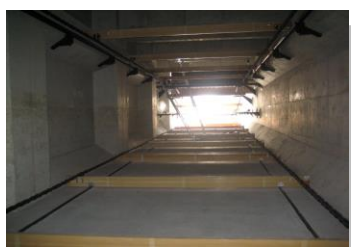
最終沈殿池の全景
