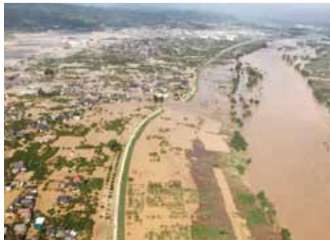
令和元年東日本台風による長野県内の洪水災害
