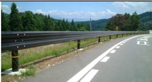
候補①ガードレール
