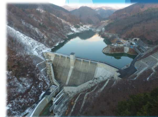
試験洪水時(平成29年1月)にサージージ水位まで貯水した状況
