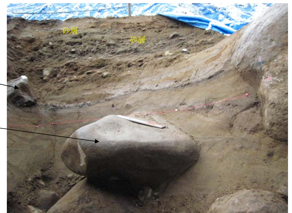
写真 3.6.3.2 山側斜面 (山側壁追い込み2回目) 砂礫層中に2枚の不連続な砂層が介在する
