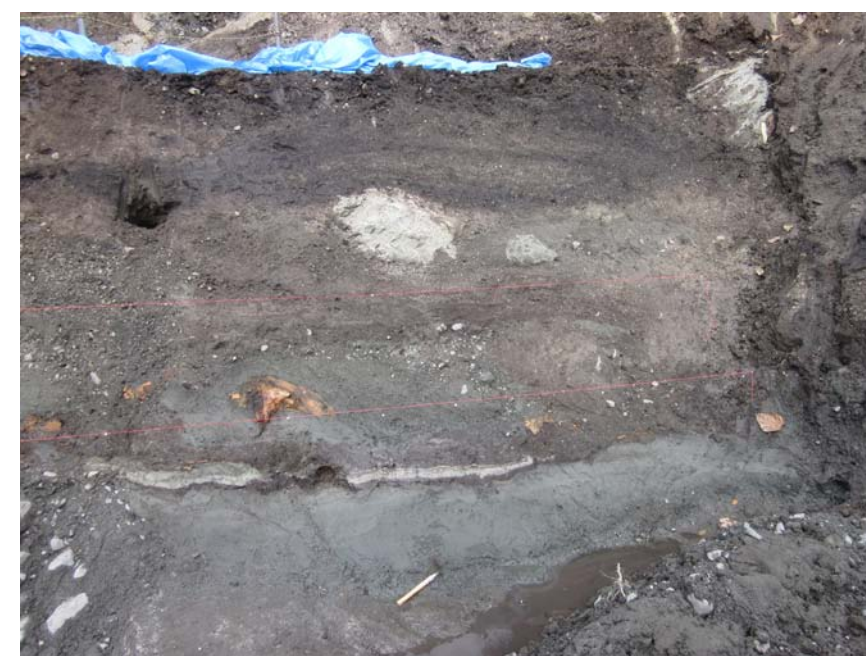
写真 3.9.1.5 トレンチ 1'下流壁地質状況写真 (被覆層) 11/16 撮影
