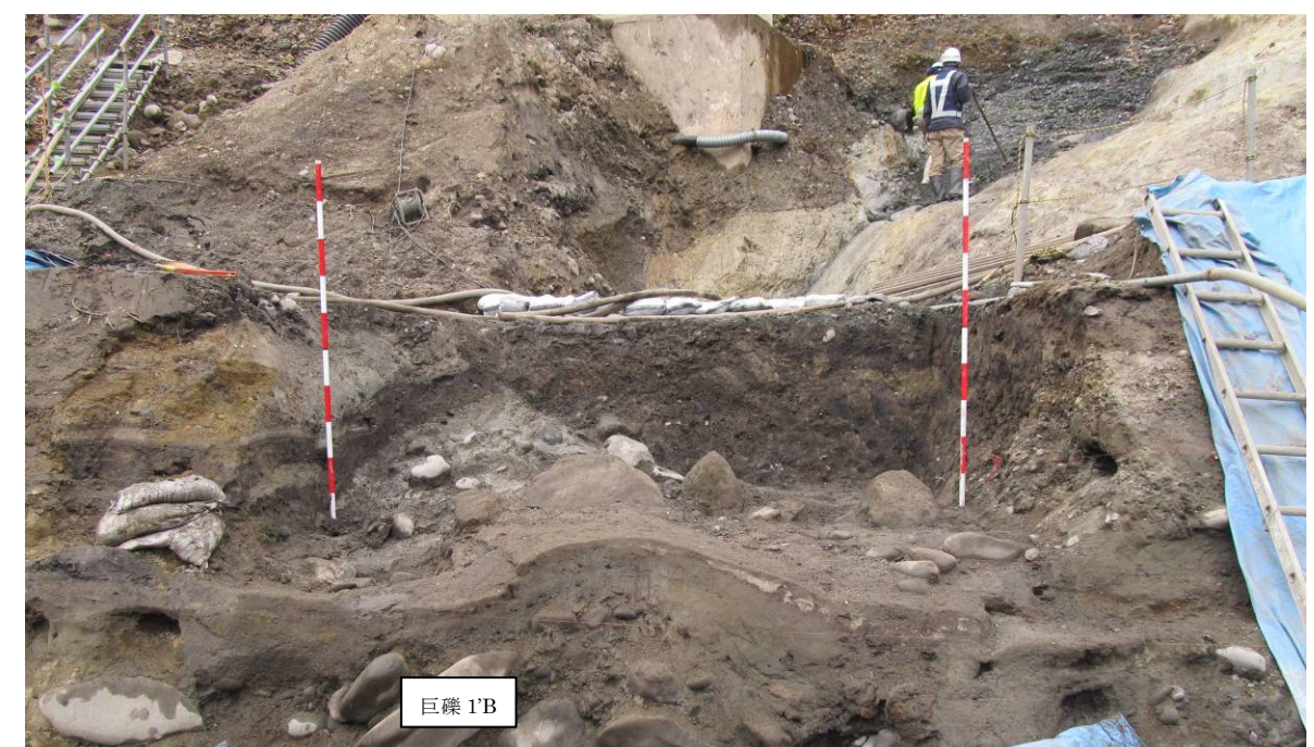
写真 3.9.1.10 有機質土たわみ部の上位層の追い込み後 (11/28 撮影)
