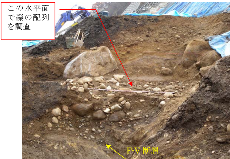
写真 3.6.4.1 トレンチ 5 を下流側に追い込み中の状況 (上流から下流を見る)
