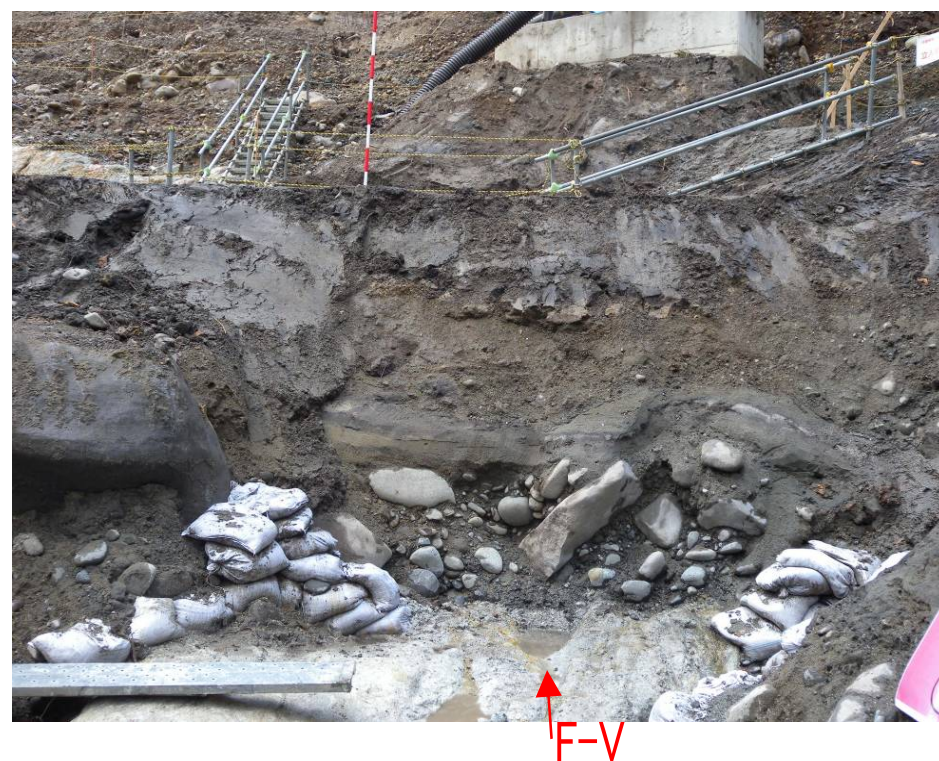
写真 3.9.1.6 10月30日時点のトレンチ 1'掘削状況
