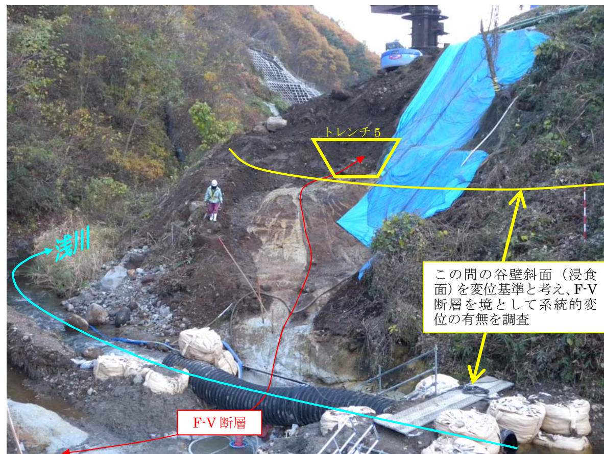
写真 3.7.1 トレンチ5 上流の岩盤面調査実施箇所の全景
