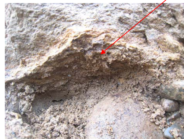
写真 3.6.2.2 砂礫が落ち込んでいる上側岩盤に擦痕は認められない。
