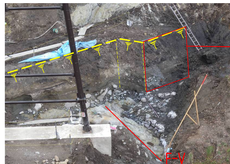
写真 3.9.1.7 トレンチ 1'全景 (11/9 撮影)
