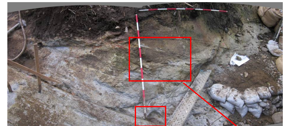
写真 3.7.1.2 岩盤面下部の状況
