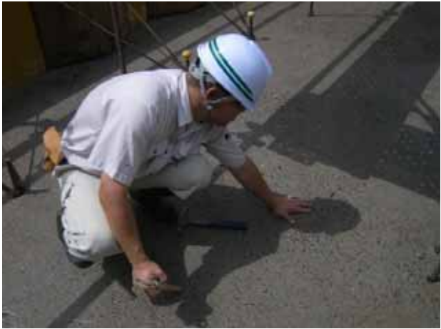
写真 6.1.5 グリーンカット面検査
