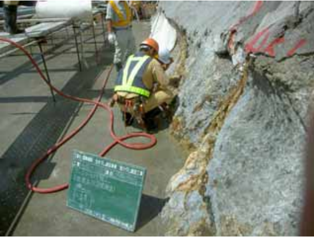
写真 6.1.3 岩盤状況検査
