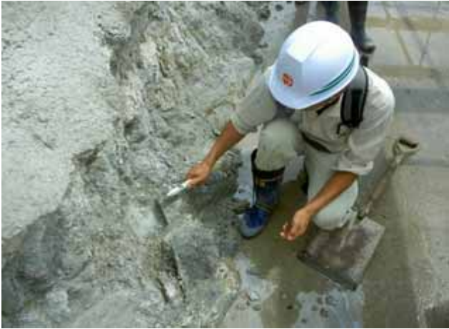
写真 6.1.4 岩盤状況検査
