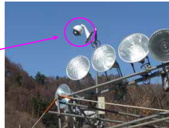
写真 3.2.3 Web カメラ設置状況
