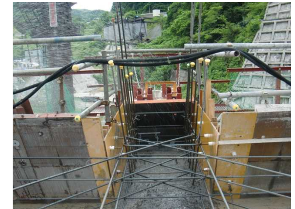
写真 3.4.16 スクリーン部の散水養生
