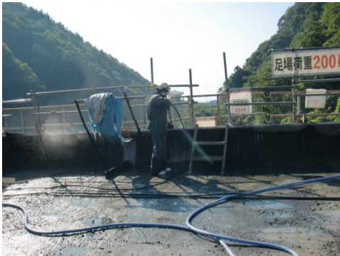
写真 3.4.5 高圧水による二次カット
