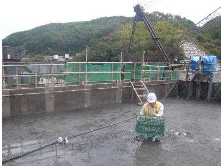
写真 3.4.3-2 GC状況の確認検査
