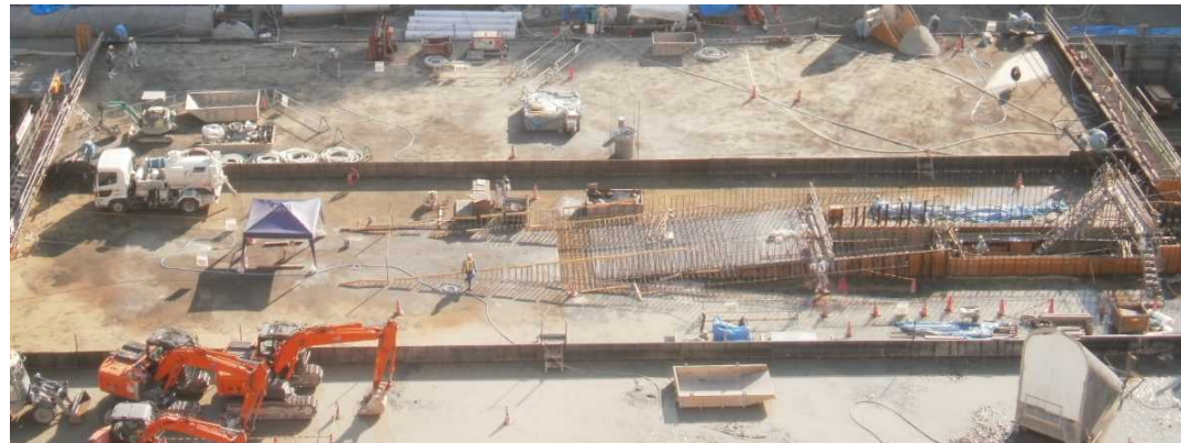
写真 3.4.19 常用洪水吐き部の打設状況(H24 年 6 月 26 日撮影)
