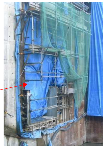
写真 3.4.21 下流吐口部シート養生
