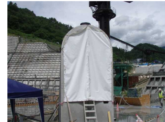
写真 3.4.17 監査廊入口ファスナーシート設置
