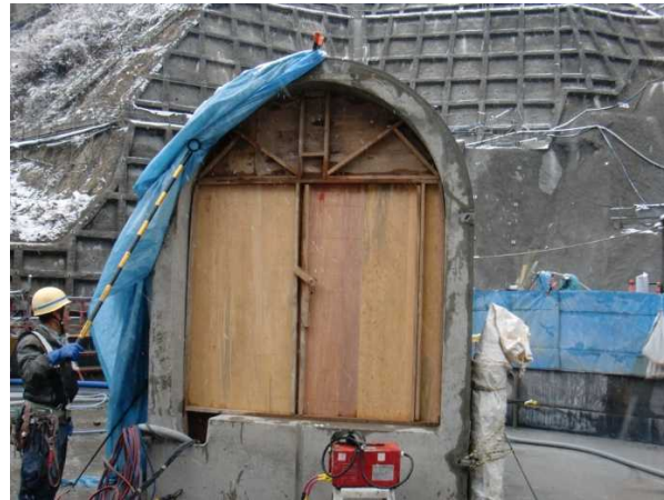
写真 3.4.33 監査廊入口扉設置(越冬養生)
