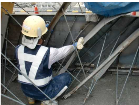
写真 3.4.8 止水板の清掃
