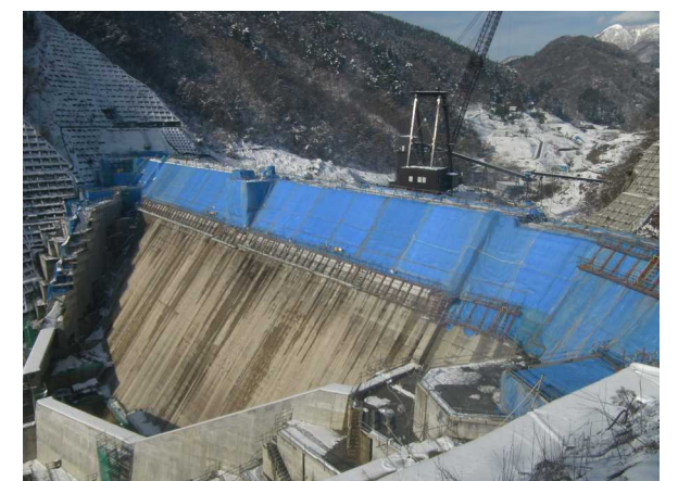
写真 3.4.32 下流面の越冬養生
