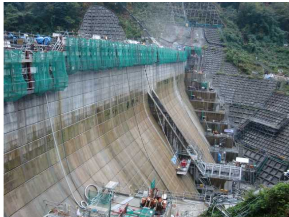
写真 3.4.11 斜面部の散水養生
