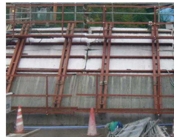
写真 3.4.14 DF 型枠の養生
