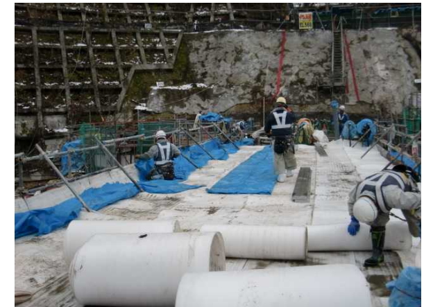
写真 3.4.28 水平打継面の越冬養生施工状況
