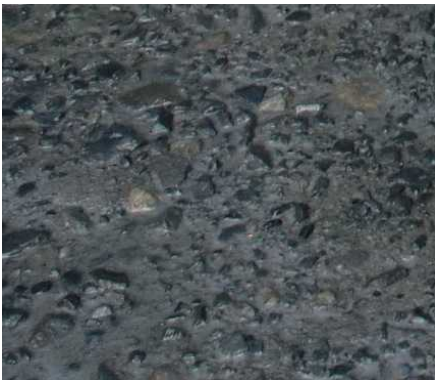
写真 3.4.6 GCマシンによる二次カット後の打設面
