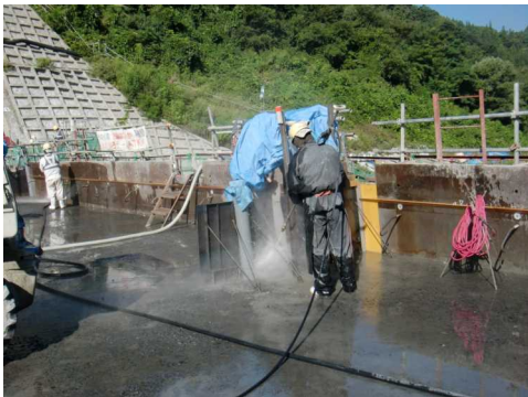
写真 3.4.7 止水板付近の二次カット
