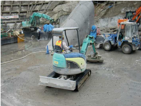
写真 3.4.4 GCマシンによる二次カット
