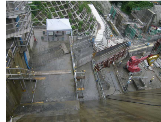
写真 3.4.15 導流壁部の散水養生
