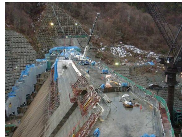
写真 3.4.29 斜面部の越冬養生施工状況
