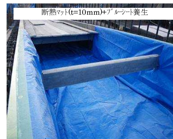
写真 3.4.18 ライニングの養生(断熱マット(t=10mm)+ブルーシート)
