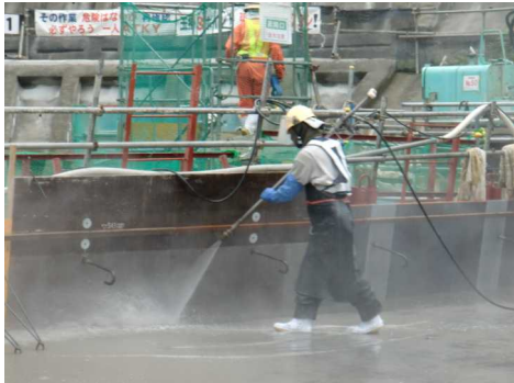
写真 3.4.2 高圧水による一次カット
