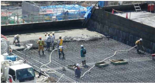
写真 3.4.35 平成 24 年越冬面配筋施工状況
