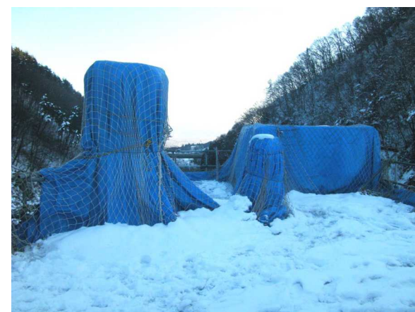
写真 3.4.31 エルベ・ツツアト周辺の越冬養生
