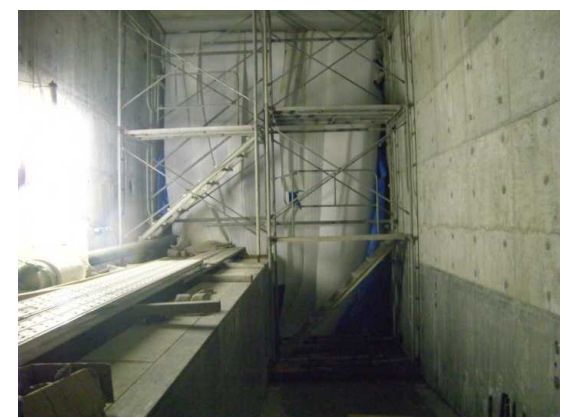
写真 3.4.26 下流吐口部断熱マット t=10mm 追加
