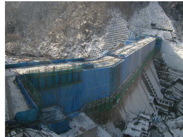
写真 3.4.27 水平打継面の越冬養生
