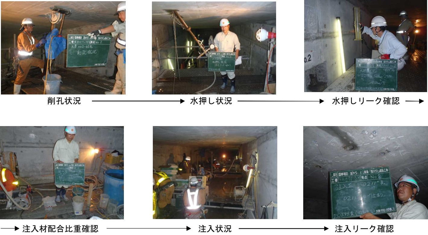
写真 3.4.37 対策③延伸したクラックのグラウチング工施工状況
