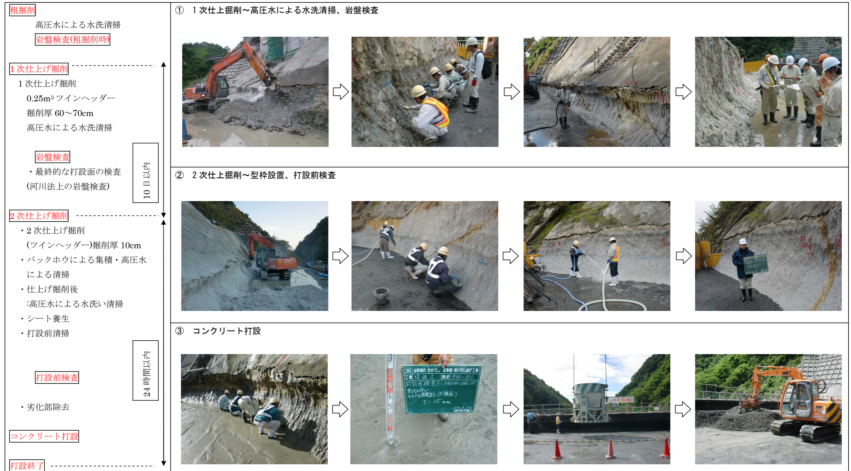
図 3.3.3 斜面部の施工状況
