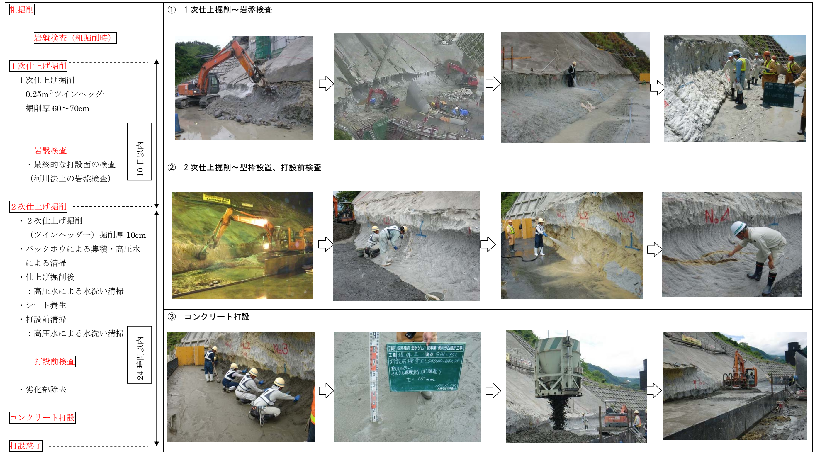
図 3.3.4 斜面部の施工状況
