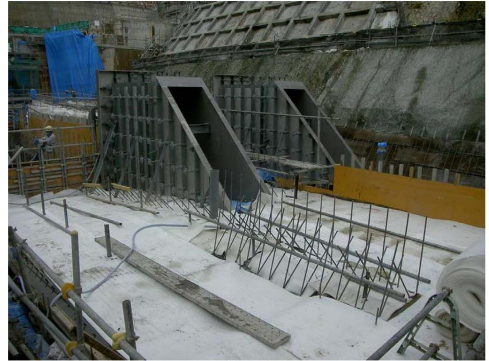
写真 3.4.19 高強度コンクリート養生状況 (断熱)
