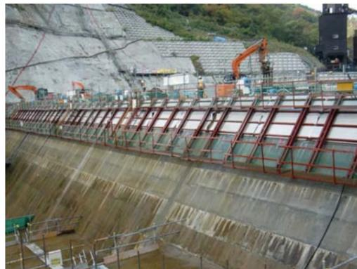
写真 3.4.13 DF型枠の養生
