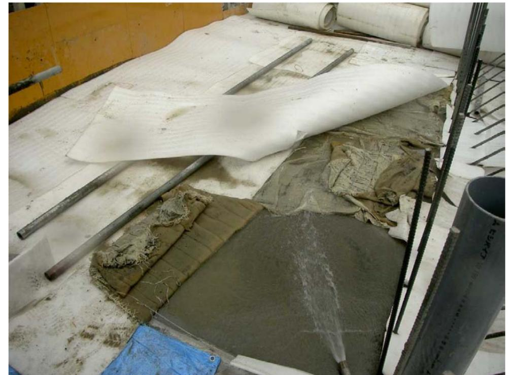
写真 3.4.20 高強度コンクリート養生状況 (湿潤)
