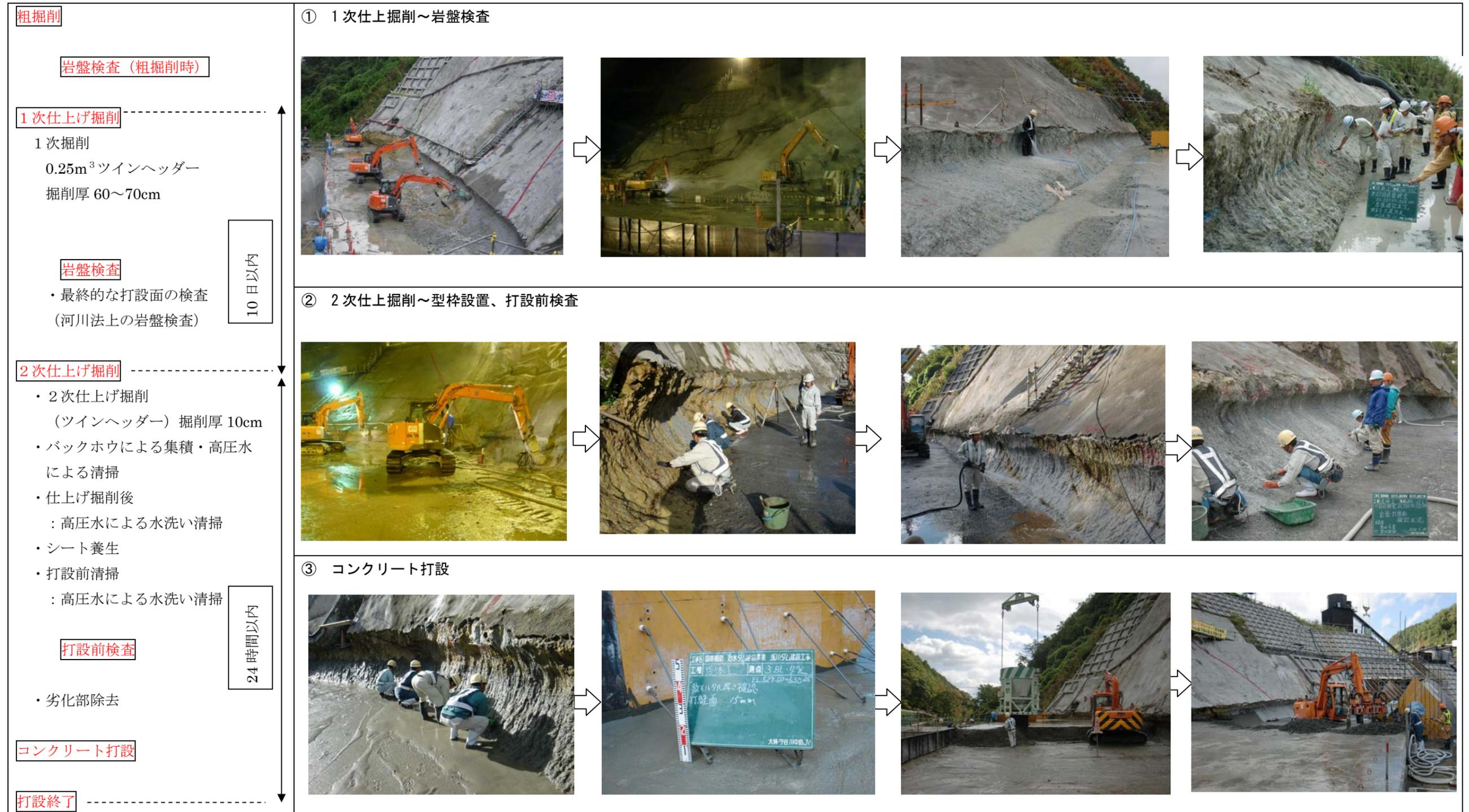
図 3.3.3 斜面部の施工状況
