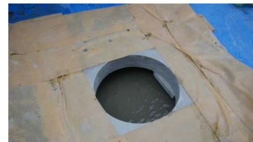
写真 3.4.17(d) 充填確認孔設置状況
