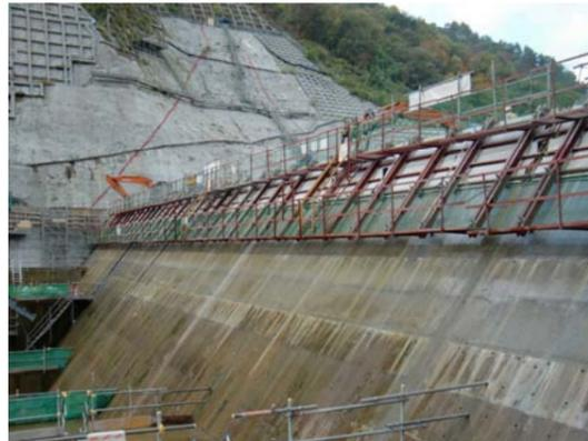
写真 3.4.11 斜面部の散水養生
