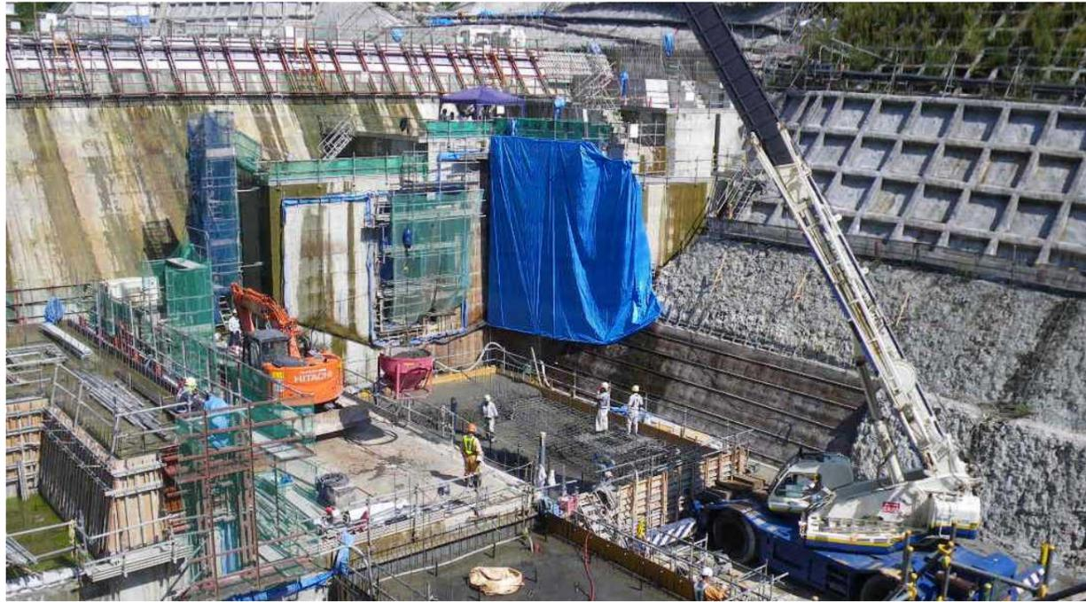
写真 3.4.18 高強度コンクリート打設状況
