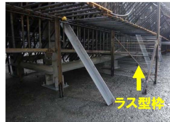
写真 3.4.17(b) ラス型枠配置
