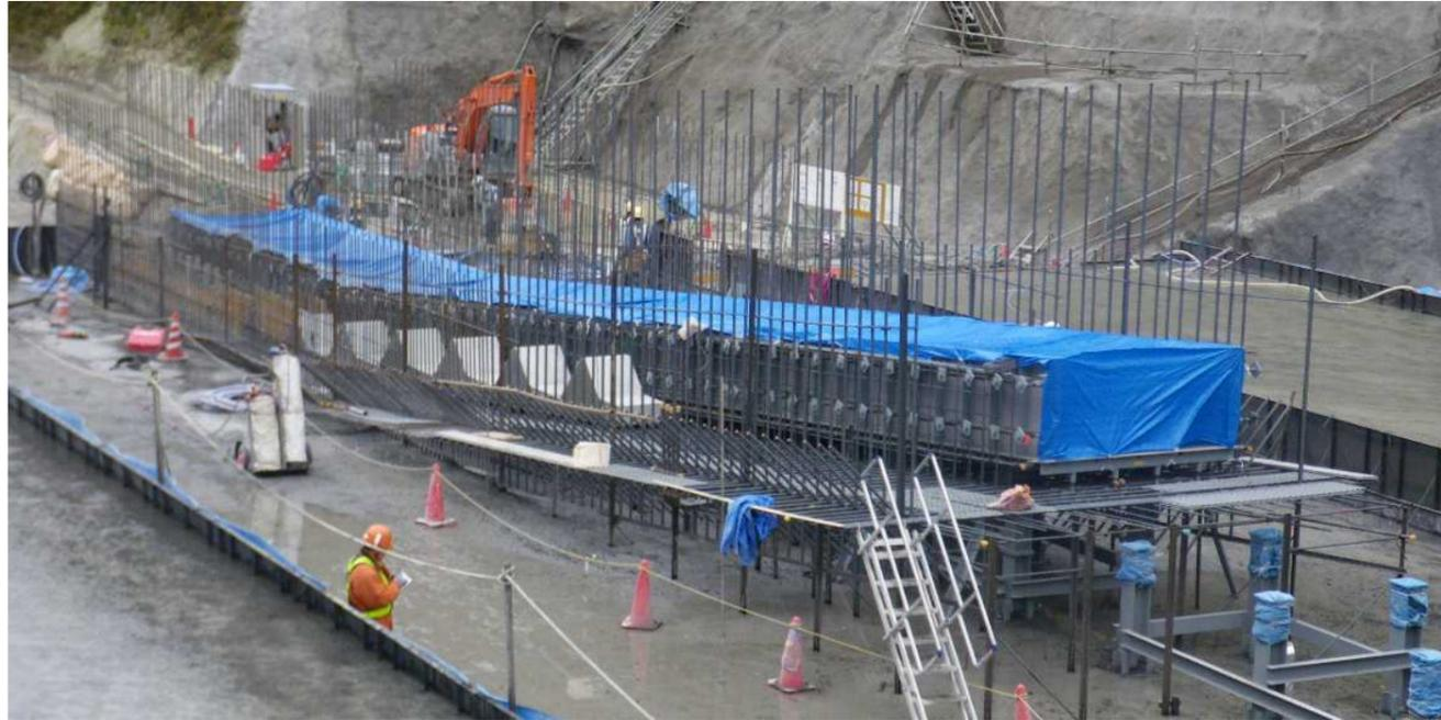
写真 3.4.15 鋼製ライニング設置状況
