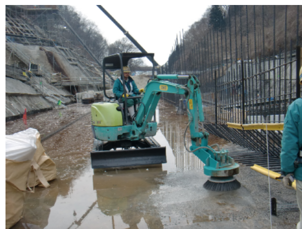
写真 3.4.11 越冬面処理 (GC マシン)
