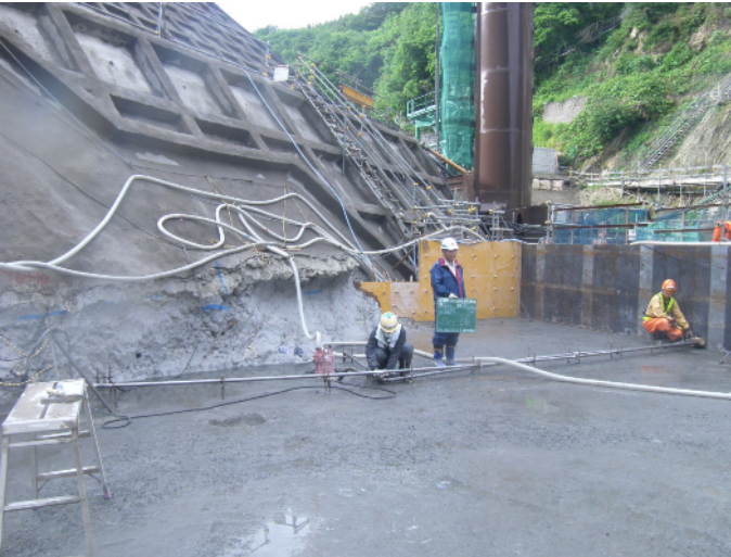
写真 3.4.1 打設前検査状況
