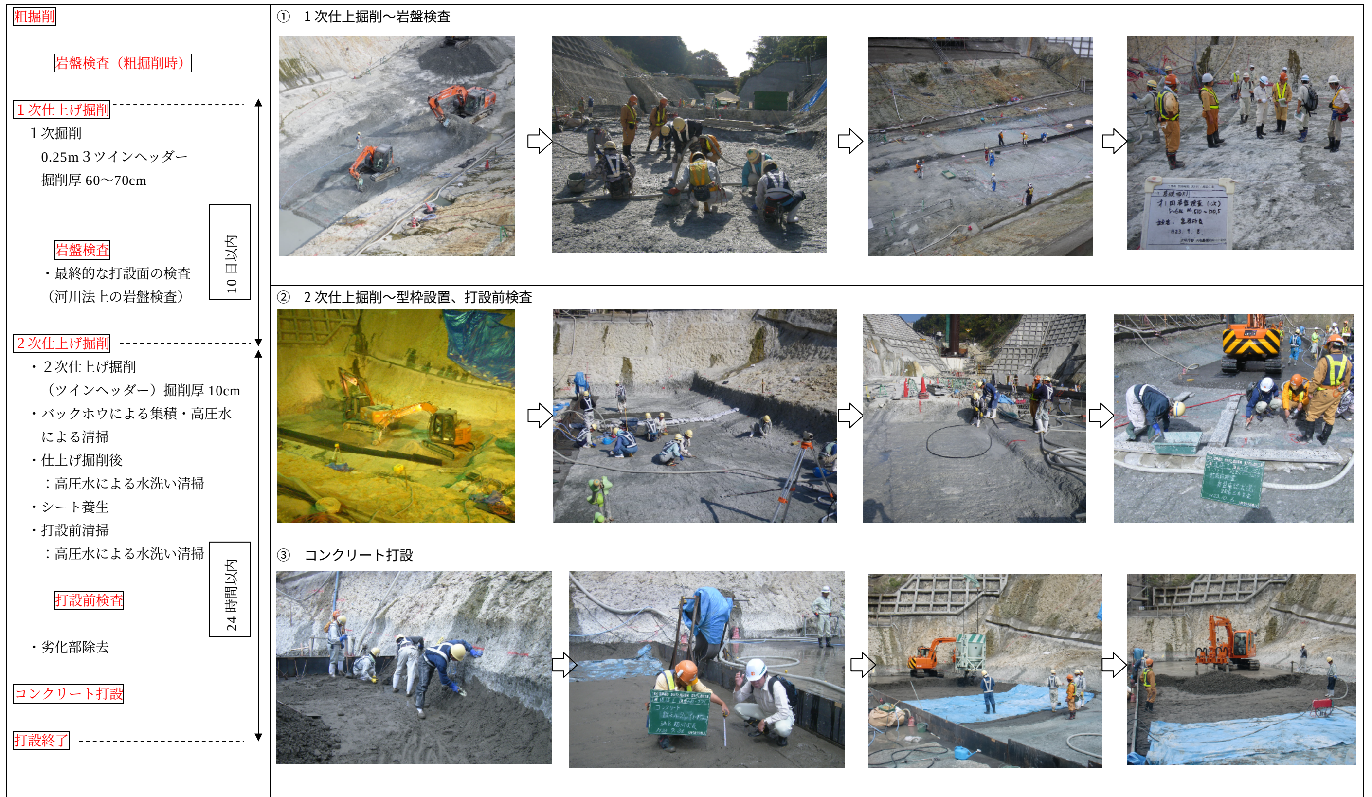
図 3.3.6 河床部の施工状況
