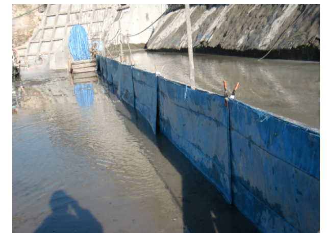
写真 3.4.5 断熱マット敷設 (ジョイント部)
