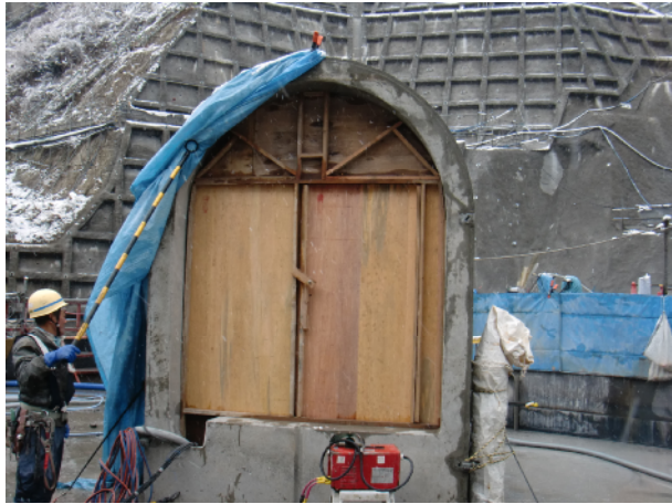
写真 3.4.7 監査廊入口扉設置
