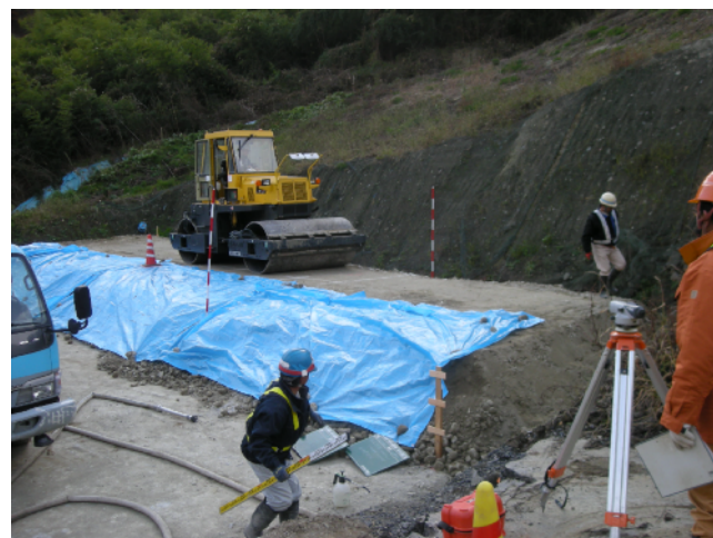
振動ローラによる転圧
