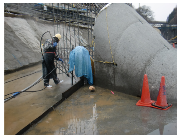
写真 3.4.12 越冬面処理 (高圧水)
