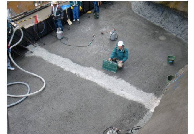
写真 3.4.14 水平止水板設置 設置面清掃・乾燥
