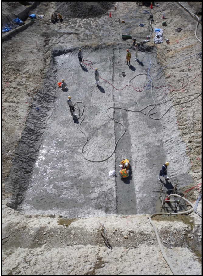
写真 3.5.1 岩盤面 割れ目がほとんど発達しない。
