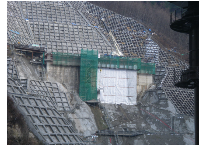
写真 3.4.3 断熱マット敷設 (造成アバット)
