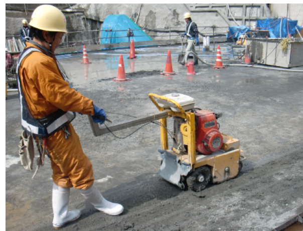
写真 3.4.9 越冬面処理 (表面研削機)
