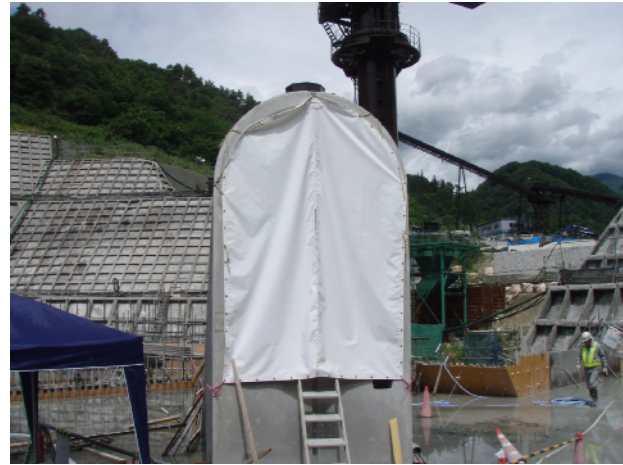
写真 3.4.8 監査廊入口ファスナーシート設
