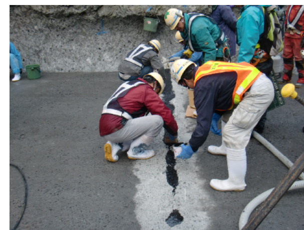
写真 3.4.15 水平止水板設置 接着剤塗布
