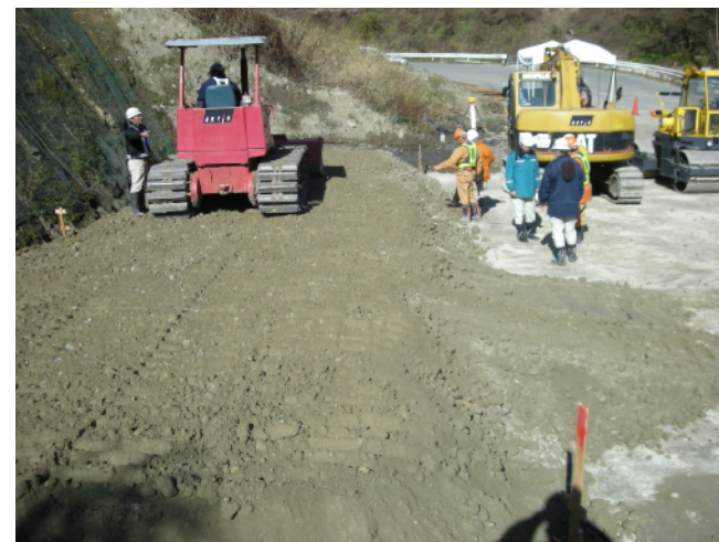
ブルドーザによる敷均し
