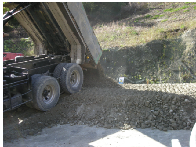
CSGの撒きだし
