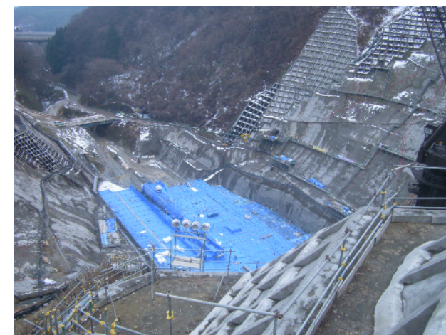
写真 3.4.4 堤体越冬養生
