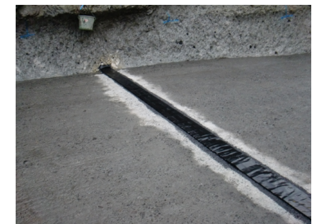
写真 3.4.16 水平止水板設置完了
