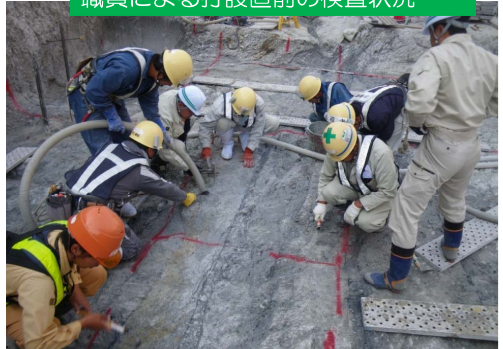
職員による打設直前の検査状況
