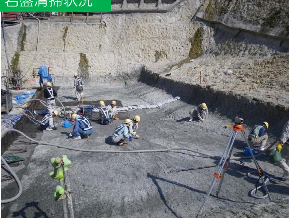
岩盤清掃状況
