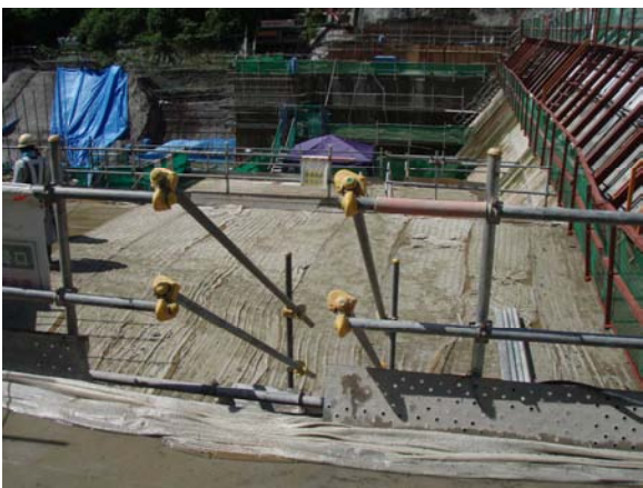
階段及び手摺り
