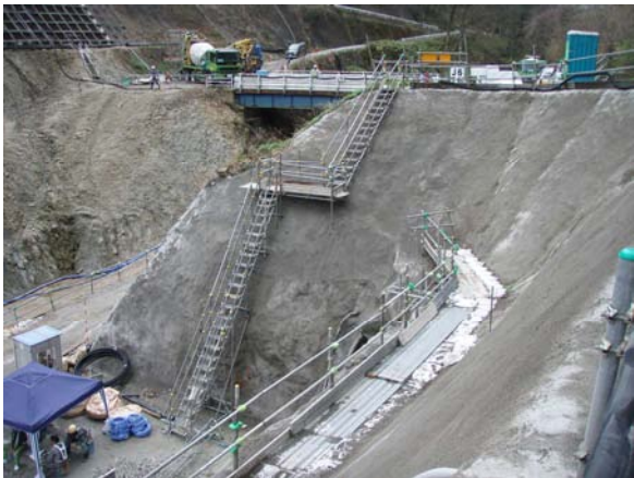
階段の設置状況
