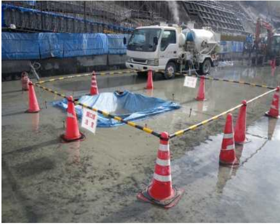
堤体打設箇所
