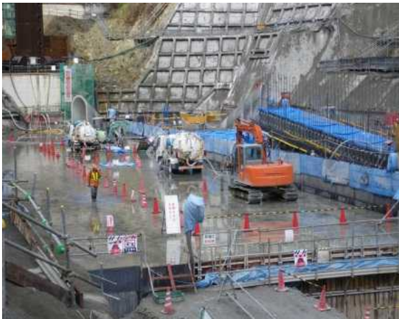
堤体打設箇所
