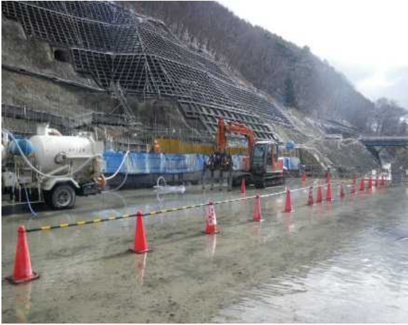
堤体打設箇所
