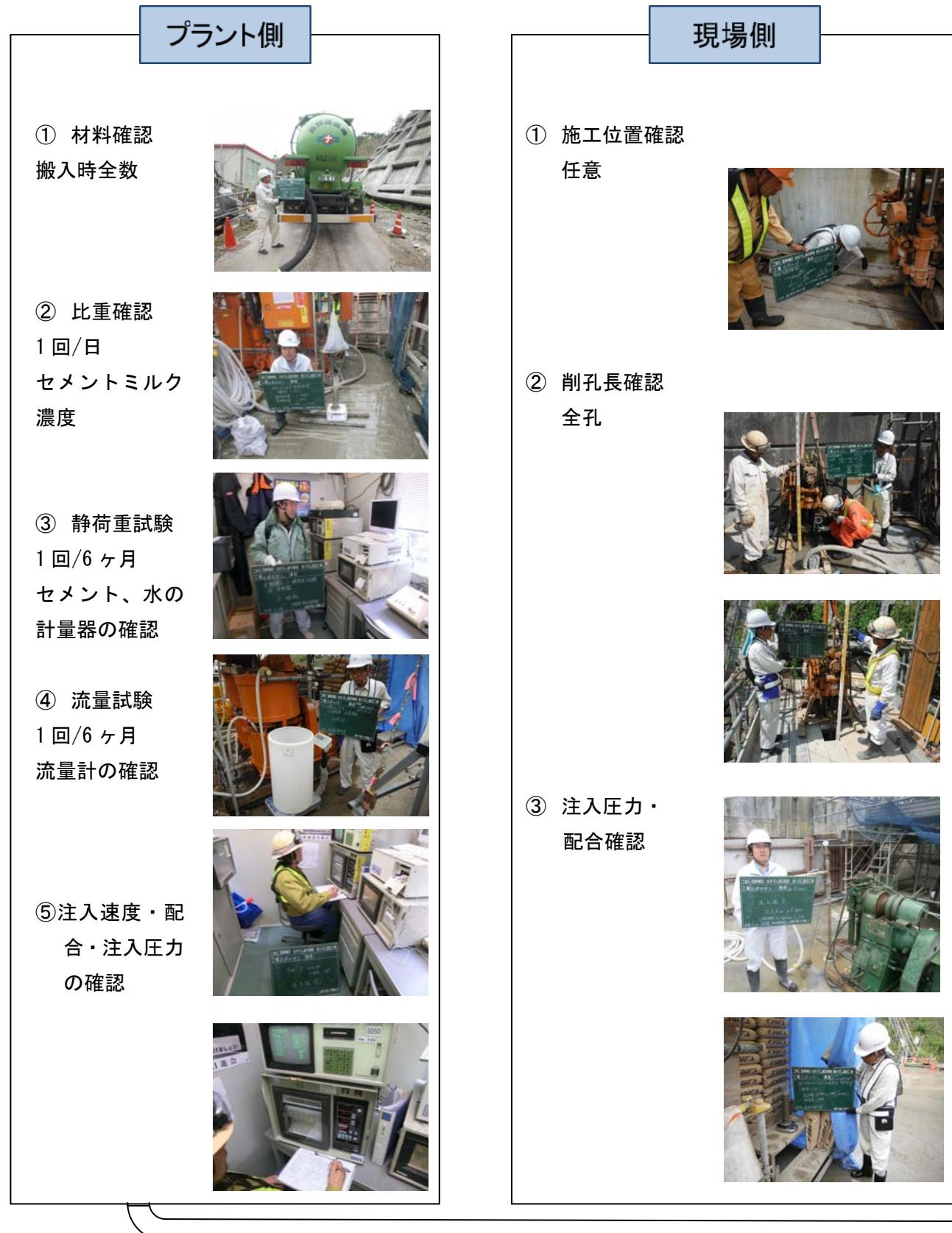
グラウチングの出来高は、ボーリング削孔長、注入量、注入時間を発注者の確認によって管理している。注入セメント量は、配合毎に計量されたミルクに対して、実注入量に応じて記録される。
