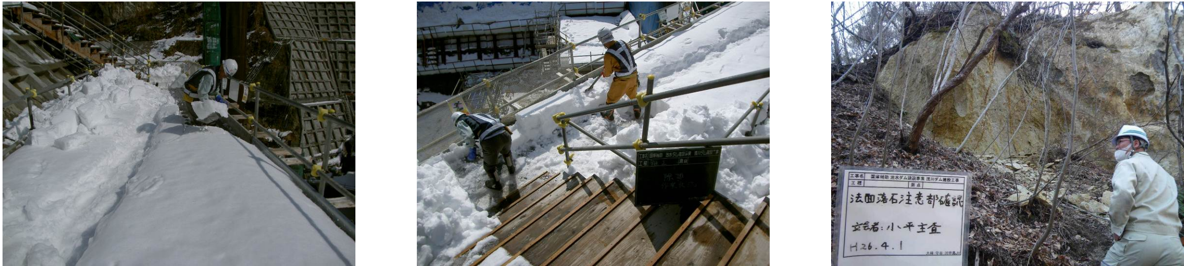
写真 4.1.2 雪崩、落雪対策の実施状況
