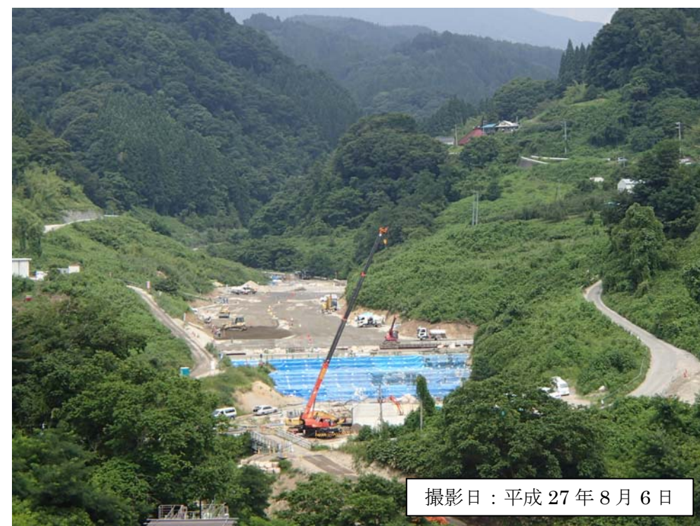
写真 3.6.1 CSG 施工状況全景写真
