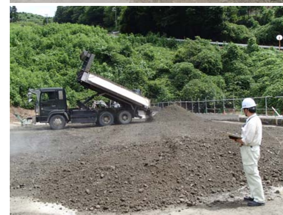
運搬（10t ダンプトラック）及び撒出し
