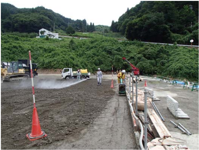
写真 3.6.4 端部転圧 (バイブロコンパクター 10 回)
