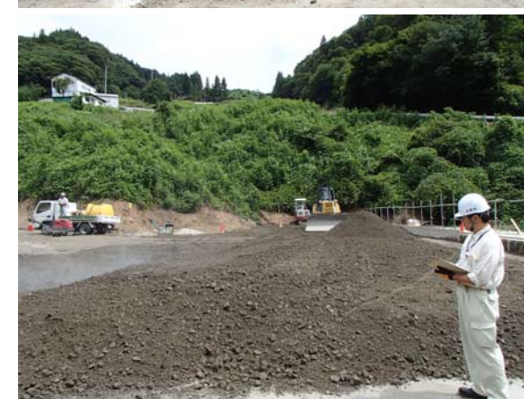
敷均し（7t 級ブルドーザ）
