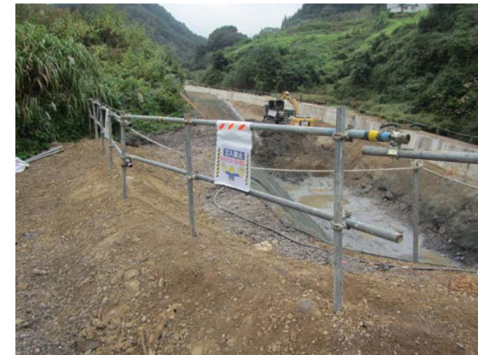
法肩区画状況
