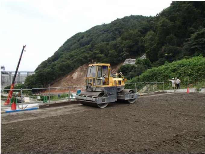
写真 3.6.3 標準部転圧 (11t ローラー 無振動 2 回・有振動 8 回)
