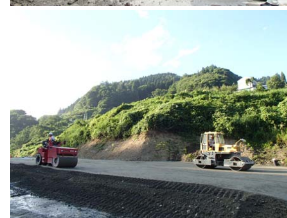
締固め（11t 級振動ローラー）
