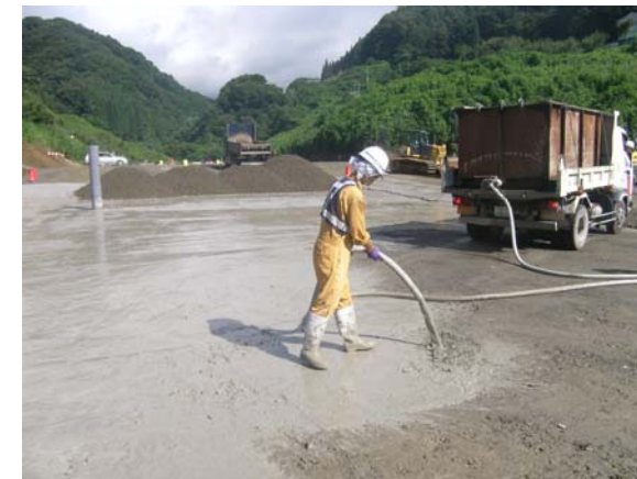
セメントペースト敷均し
