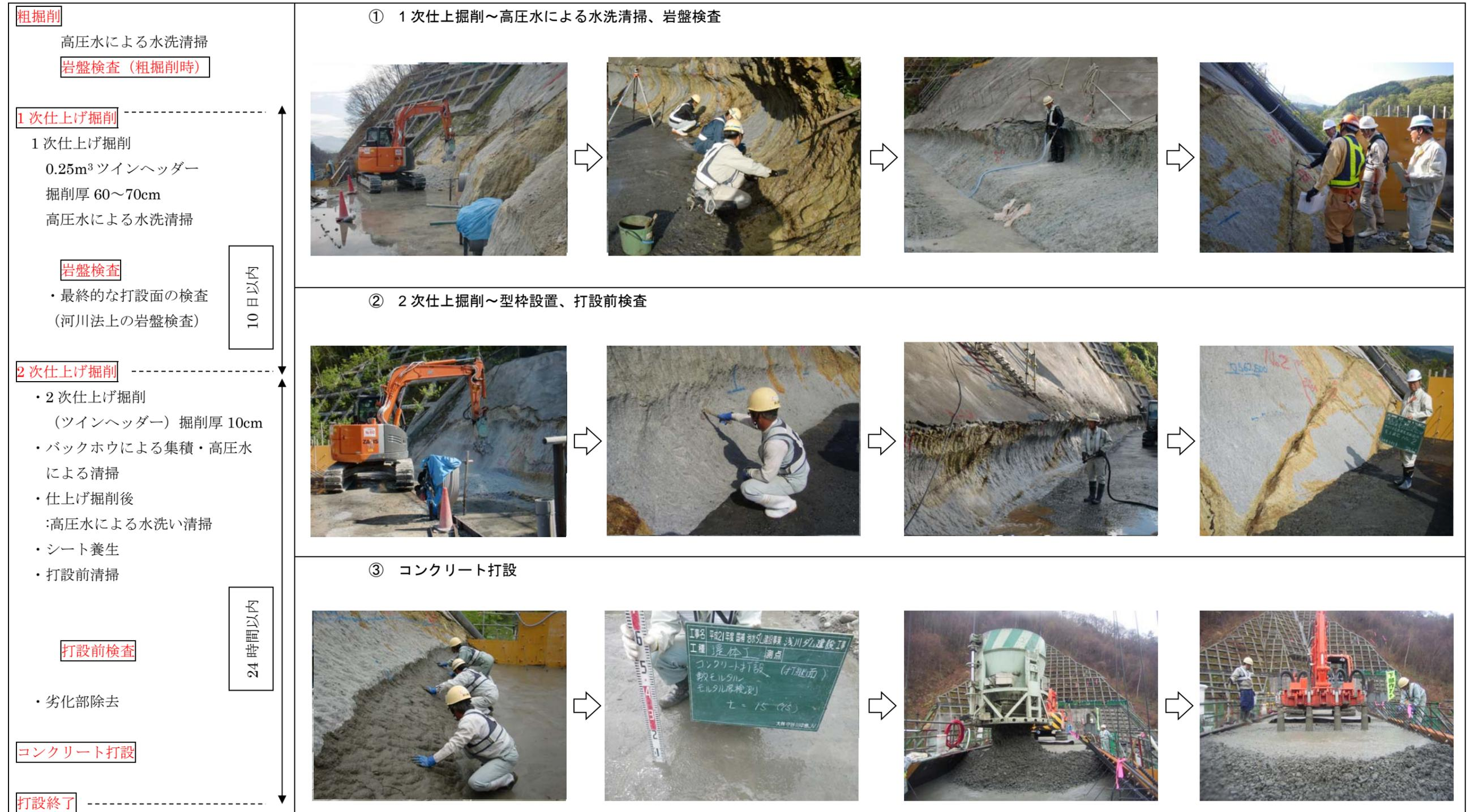
図 3.3.4 斜面部の施工状況
