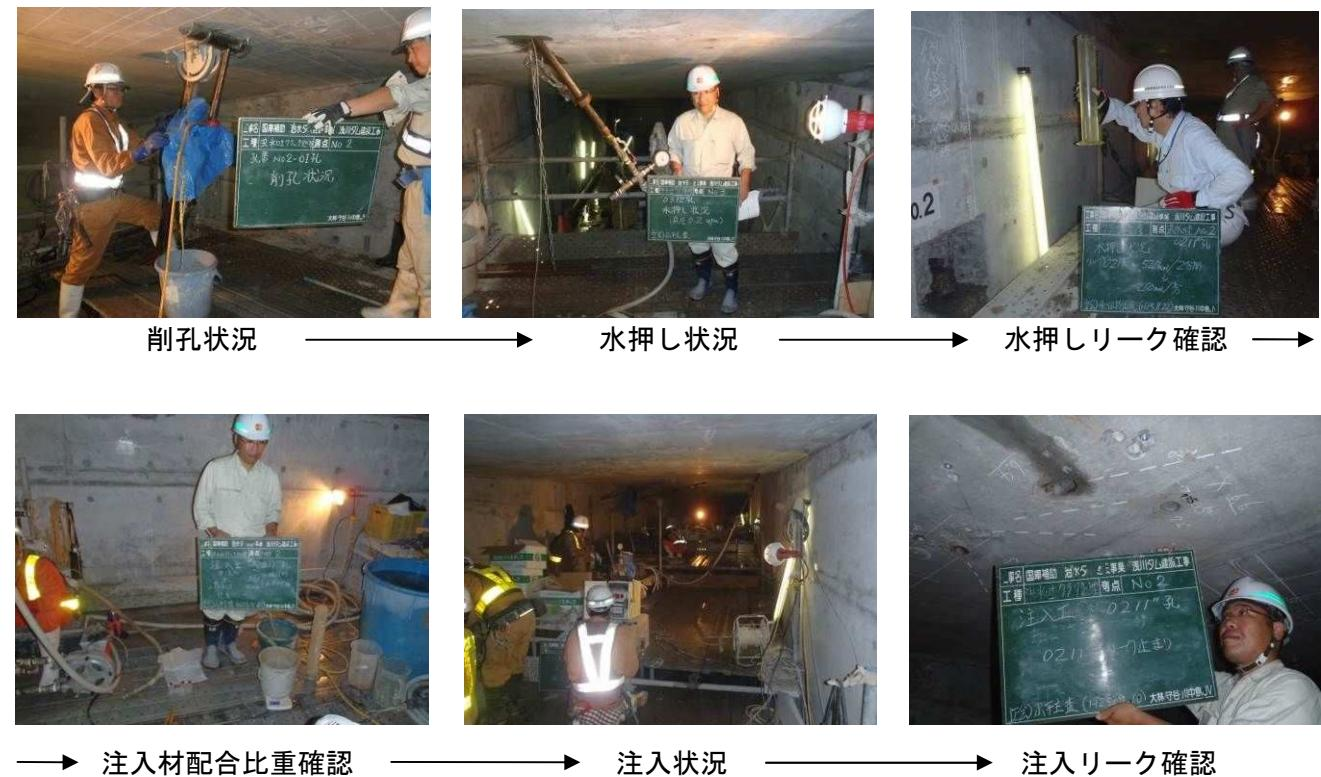
写真 3.4.36 延伸したクラックのグラウチング工施工状況
