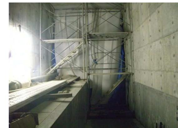
写真 3.4.26 下流呑吐口部断熱マット( $t=10\text{mm}$  追加)
