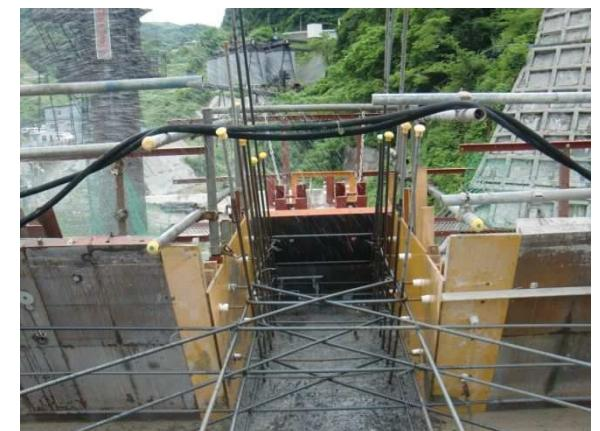
写真 3.4.16 スクリーン部の散水養生
