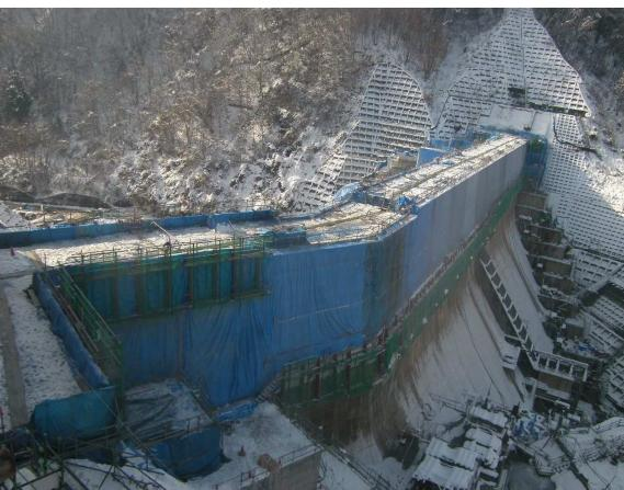
写真 3.4.27 水平打継面の越冬養生
