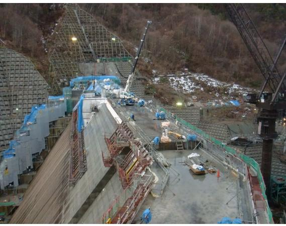
写真 3.4.29 斜面部の越冬養生施工状況
