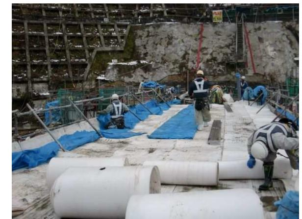
写真 3.4.28 水平打継面の越冬養生施工状況
