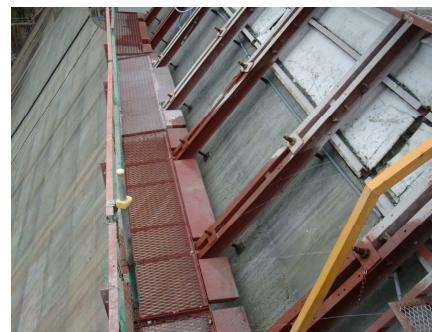
写真 3.4.12 斜面部の散水養生
