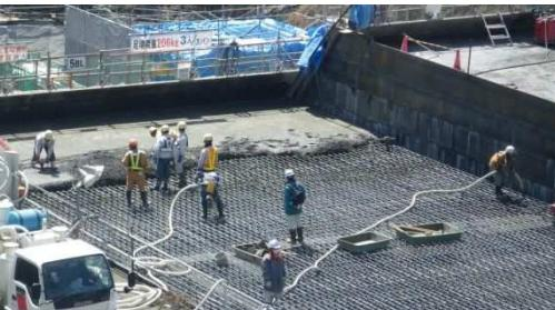
写真 3.4.35 平成 24 年越冬面配筋施工状況
