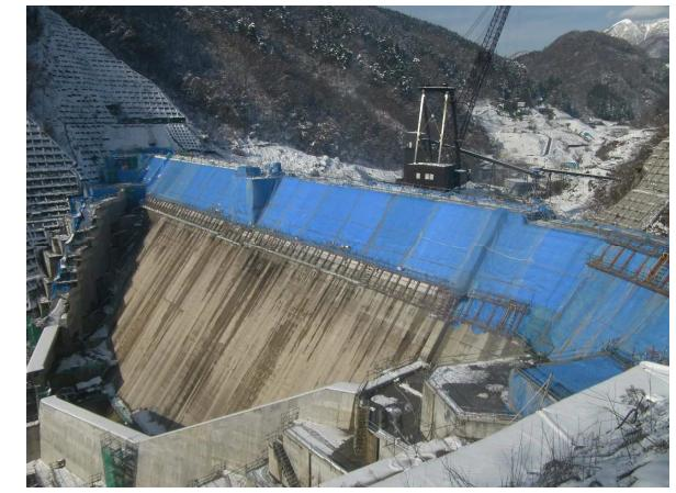
写真 3.4.32 下流面の越冬養生
