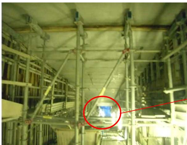
写真 3.4.20 型枠存置養生(写真奥は呑吐口ブルーシート養生)
