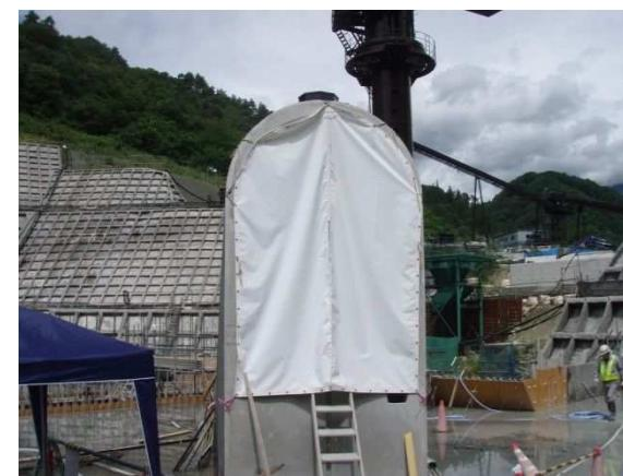
写真 3.4.17 監査廊入口ファスナーシート設置
