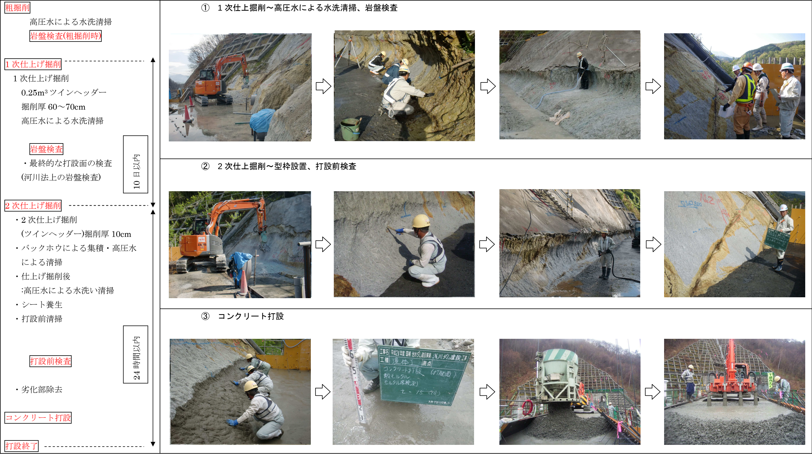
図 3.3.3 斜面部の施工状況
