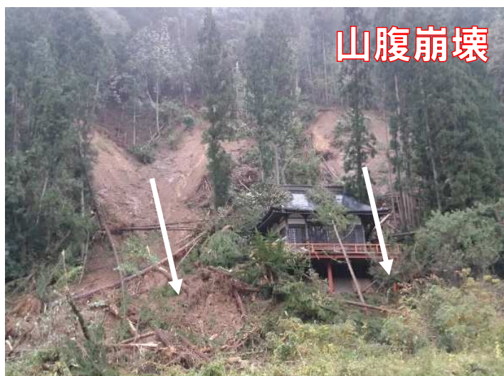
山腹崩壊により建物が被災
