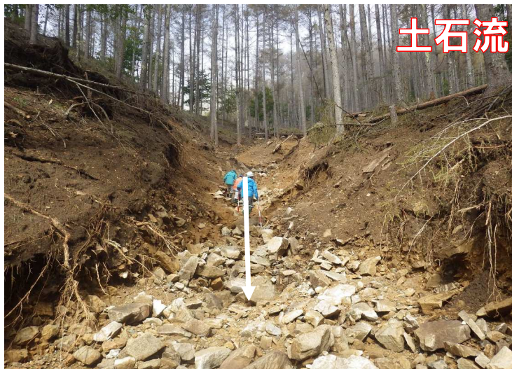
荒廃溪流から土石流が発生し村道が被災
