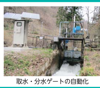
頭首工など重要構造物の耐震・長寿命化
