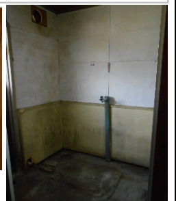
浴室 スペースのみ
