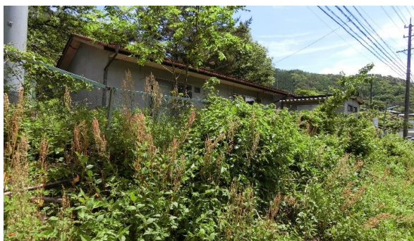
敷地4262-6南西角から
