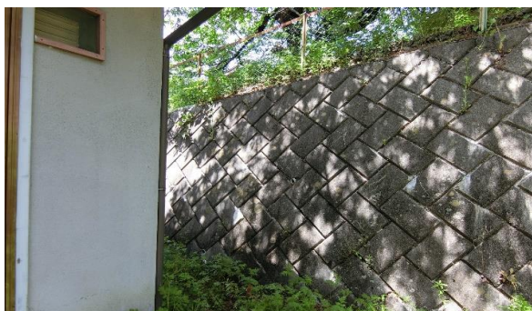
敷地4263-1北東角から
