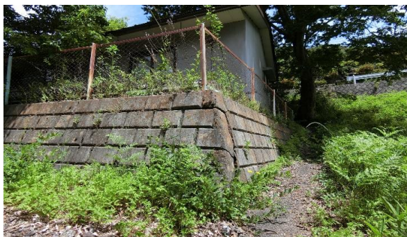
敷地4262-1南東角から
