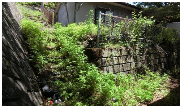
敷地4262-1南西角から
