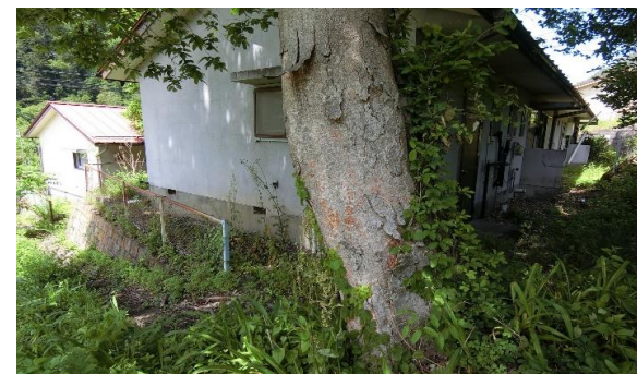
敷地4262-1北東角から
