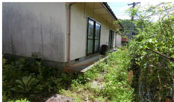
敷地4263-1南西から
