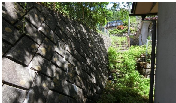
敷地4263-3南東角から
