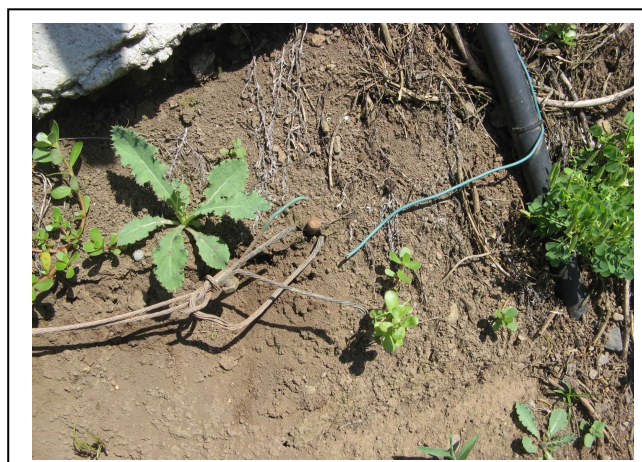
点検による発見箇所(アース線の切断)
