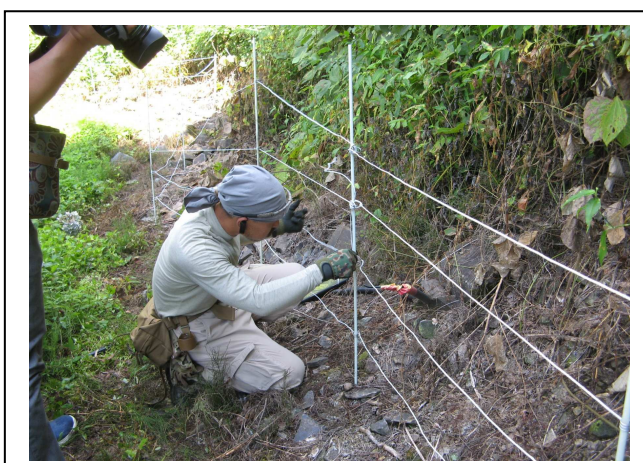
修復の状況(木島平村内山地区)
