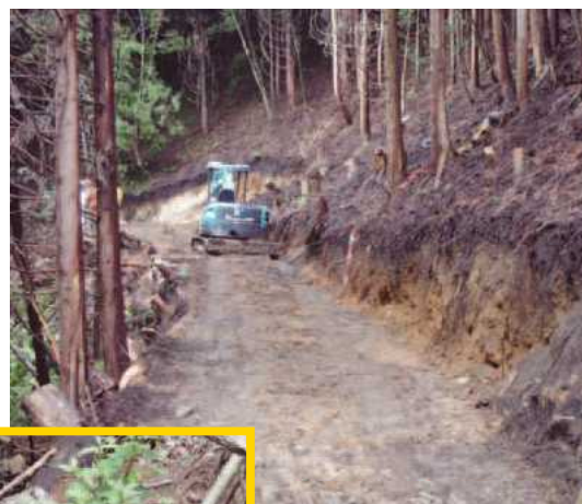
【写真ⅢⅣ】切土高を抑え、根株を利用した四万十式作業路（上）と、路側に積まれ萌芽した広葉樹の根株（左）
