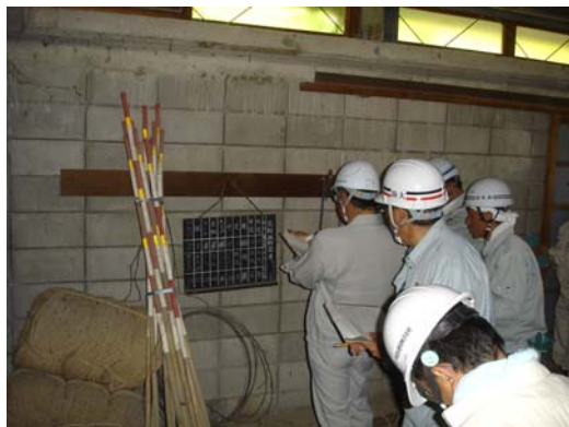
③水防倉庫内での点検状況です
