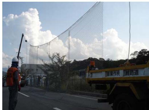
④設置完了
