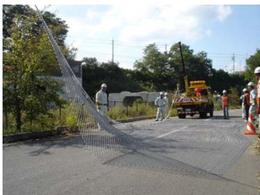
③クレーンで吊り上げる
