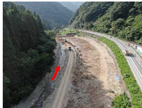
仙仁堰堤(除石施工中)
