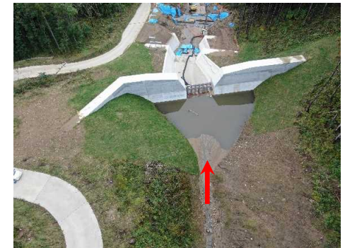
(砂)福沢 仁礼の砂防堰堤(施工中) 令和元年東日本台風の際、上流からの土砂を補足し下流への被害を防いだ
