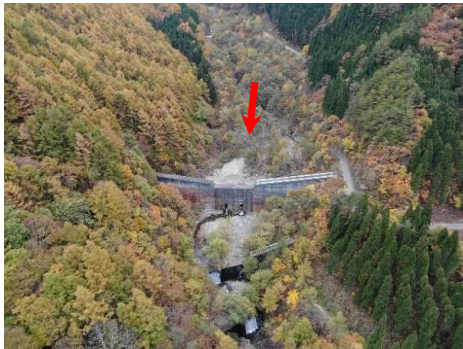
金山第2堰堤(昭和60年2月竣工)
