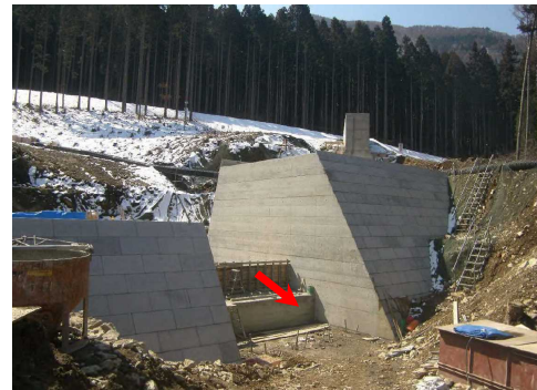
(砂)前山沢 八町の砂防堰堤(施工中) R2年度の完了を目指す
