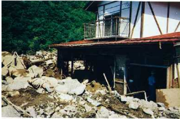
S56.8 瀬の脇地区の状況
