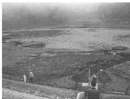
図2 ほぼ水抜きが完了した大座法師池
