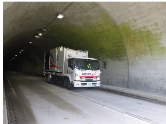
<走行画像計測システムによるトンネル点検>
