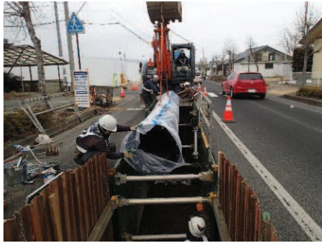
<管路の耐震化工事>
