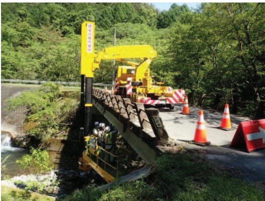
<橋梁点検車による近接目視点>
