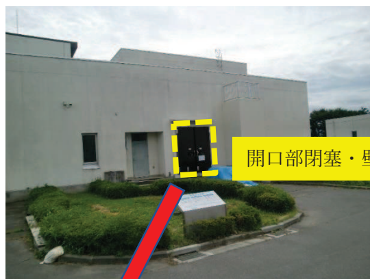
(放流ポンプ棟耐水化)
