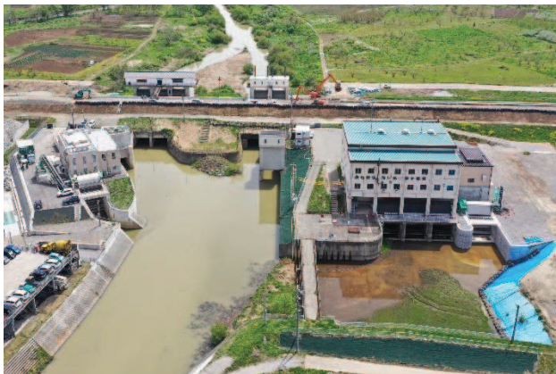
<浅川排水機場>
