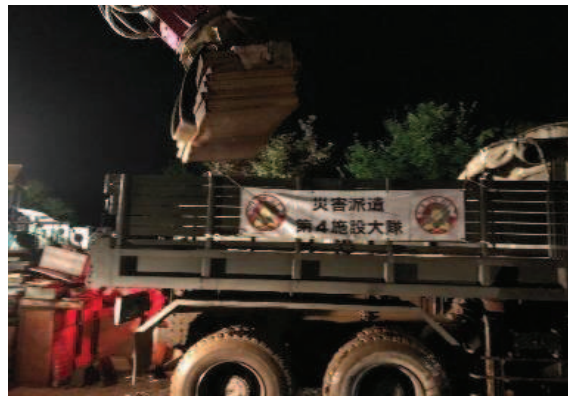
(自衛隊による搬出作業)
