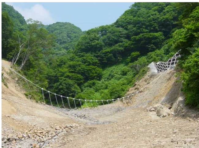
濁沢ワイヤネット式砂防えん堤
