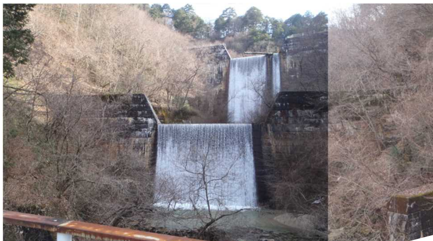
下流の橋から望む与川砂防ダム
