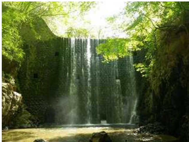
正面から見た石積堰堤
