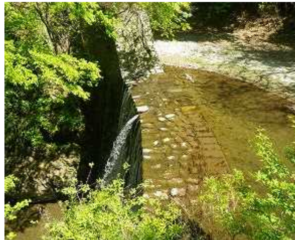
水通し、天端も石材を使用しています。
