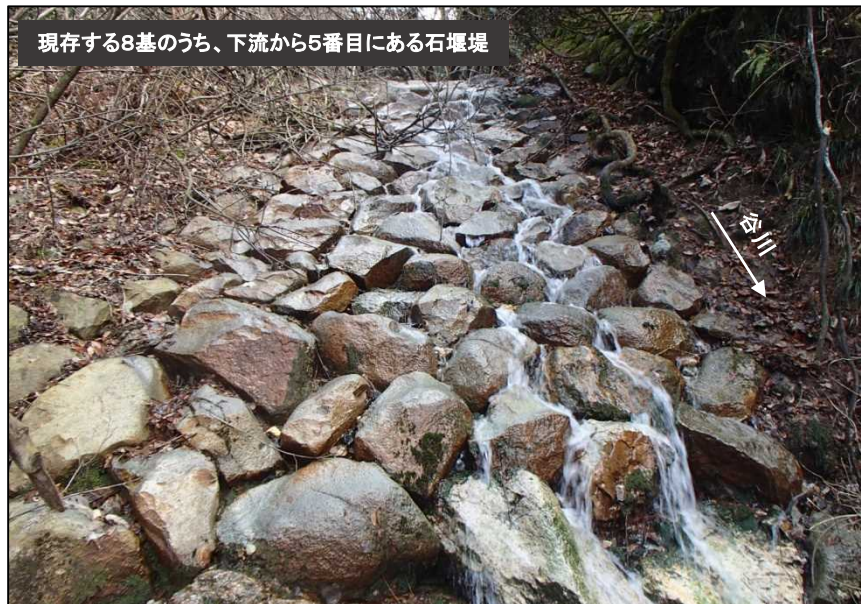
全ての堰堤が石を谷積みしている
