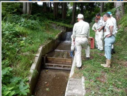
維持管理し易い工夫がなされた堂の沢農業用取水施設
