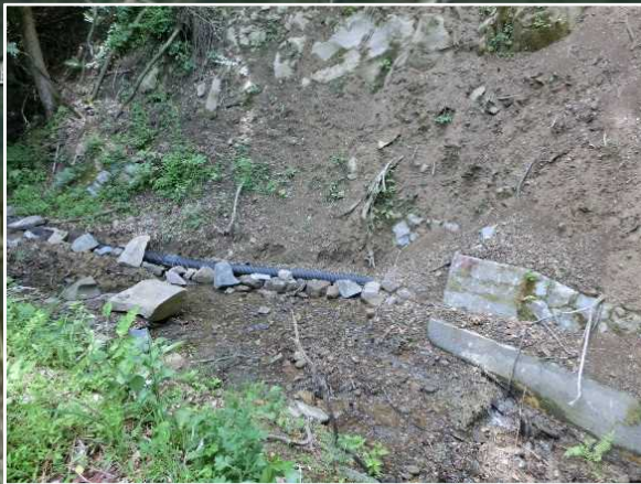
平成25年11月斜面崩壊により溪床に土砂が流入 松本市が利水機能を確保
