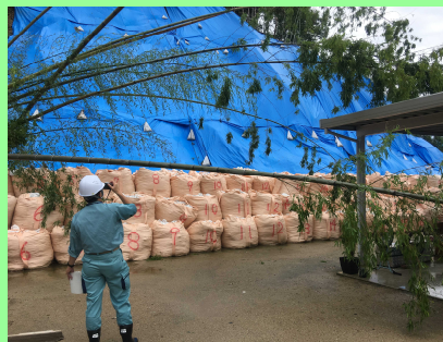
現地調査（御船町内急傾斜地）
