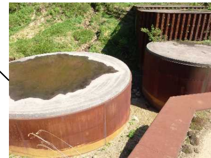
土谷川 鋼製セル堰堤 H=10m,L=78.8m,V=13,480m 3
