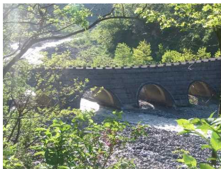
浦川 スーパー暗渠堰堤 H=11m,L=120.4m 大暗渠半径4m×4ヶ所
