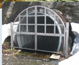
倉下地区に設置された排水トンネル
