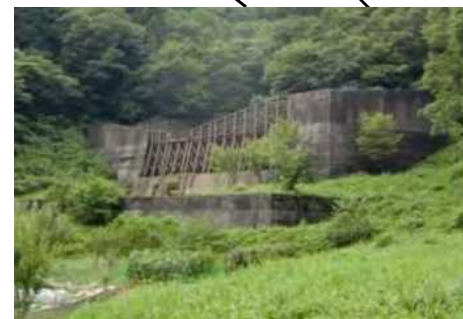
大雪沢 鋼製スリット堰堤 H=14m,L=101m,鋼材80.4t
