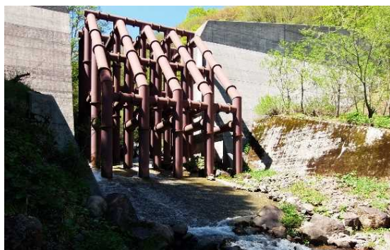
黒川 鋼製フレーム堰堤 H=15.5m,L=70.7m,鋼材φ600mm
