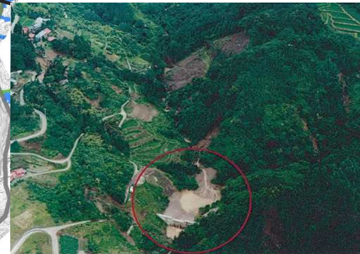
平成7年7月災害で効果を 発揮した砂防堰堤 例) 北尾沢砂防堰堤
