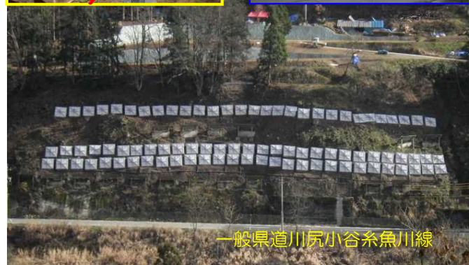
アンカー工及び地下水排除工の完成（H27.11.30）
