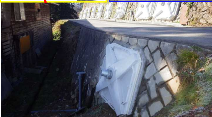
アンカー工及び地下水排除工の完成（H27.11.30）
