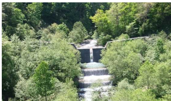
西親沢 コンクリートスリット堰堤 H=10m,L=95m,V=8,150m 3 ,スリット幅1.5m
