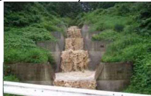
日かげ沢 階段状床固工群 高さ4～5m,落差2.3～4.1m
