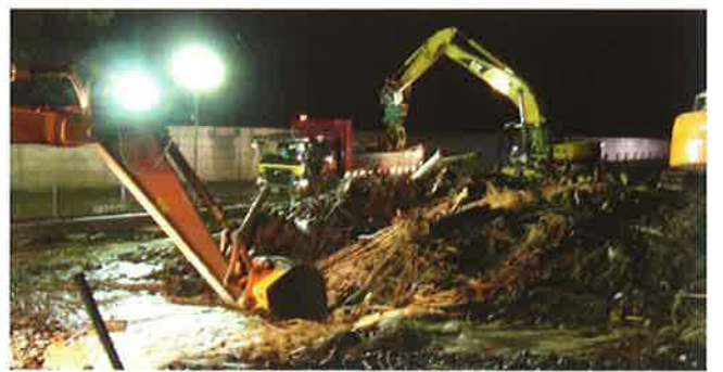
前沢川 (中央道)
