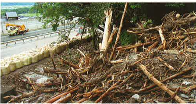
前沢川 (中央道)
