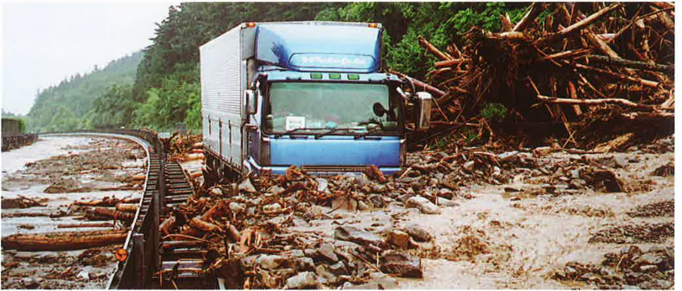
前沢川 (中央道)
